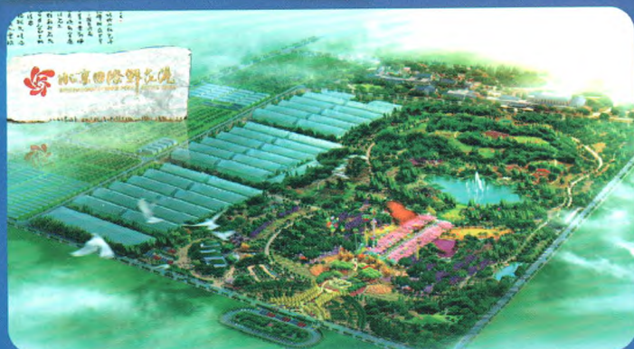
■ 北京国际鲜花港一期地源+水源+地热+燃气锅炉调峰供暖系统工程
