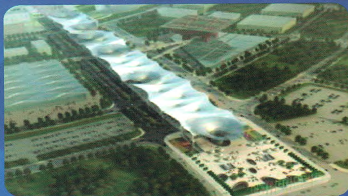
■ 世博轴地源+江水源热泵中央空调系统工程
