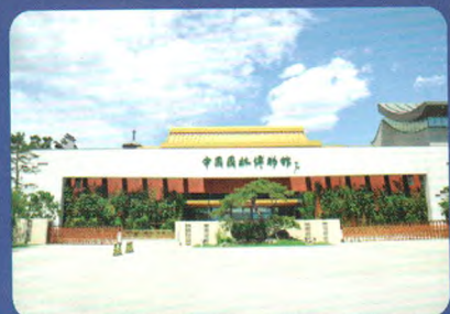
■ 第九届中国（北京）国际园林博览会地源热泵工程
