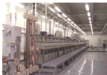
电子元件电镀生产线
