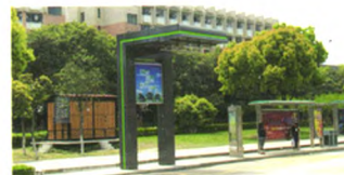
※ 储能式充电站
