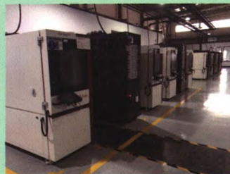
电池充放电性能测试区
