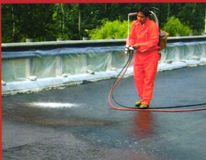
桥面粘结防水涂料的喷涂
