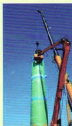
济南二环南路提升泵站 日排水量68500m 3 /d 筒径3800mm 高度16m 配3台 Q=950m 3 /h H=17m P=75kw 潜水排污泵
