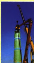
济南二环路提升泵站 日排水量6850m 3 /d 筒径3800mm 高度14m 配3台 Q=950m 3 /h H=17m P=75kw 潜水排污泵
