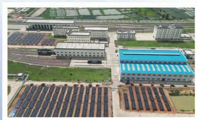
中老铁路万象南机务段光伏发电项目先行示范段
