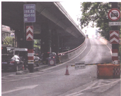
中河上塘高架匝道管控
