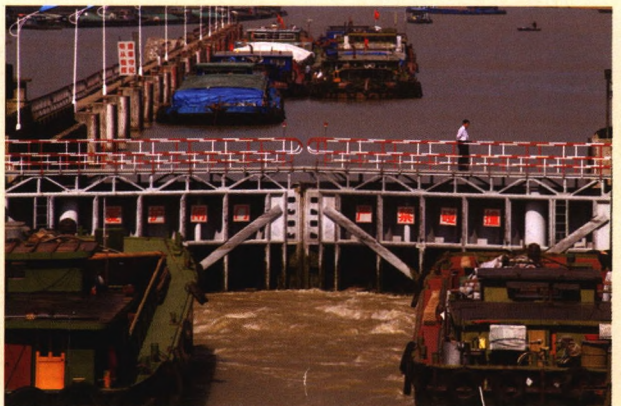
运河闸坝（淮安·季瑶拍摄）
