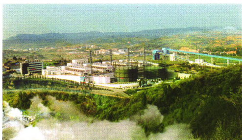
晋煤集团寺河煤层气电厂
