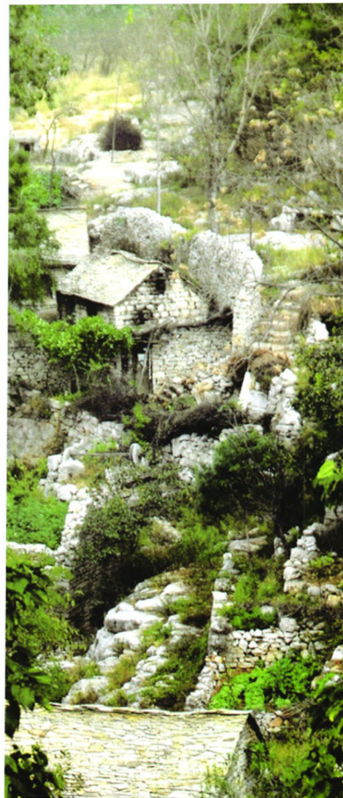
鲁南石板房部落
