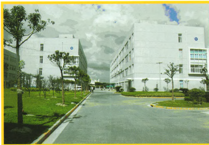
无锡钱桥助剂厂
