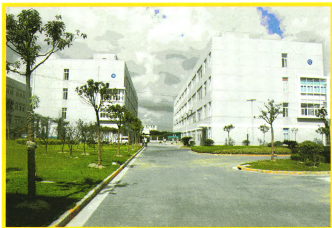
无锡钱桥助剂厂
