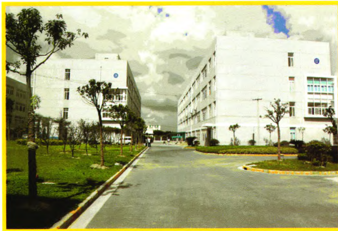
无锡钱桥助剂厂
