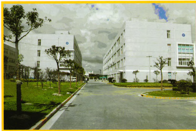
无锡钱桥助剂厂
