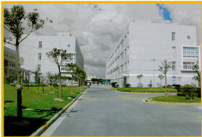
无锡钱桥助剂厂
