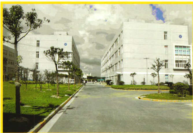
无锡钱桥助剂厂
