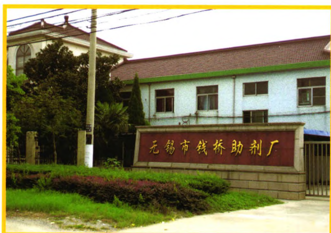
无锡钱桥助剂厂
