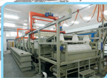
滚镀自动开盖生产线
