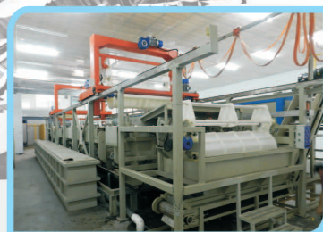
滚镀自动开盖生产线
