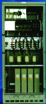
晶闸管投切谐滤波器
