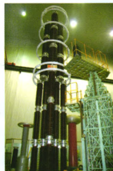
TBF 耦合电容器装置
