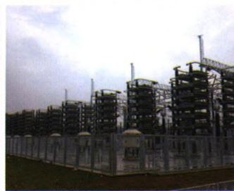
溪洛渡左岸-金华±800kV 特高压直流输电工程
