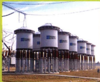
准东—华东 1100kV 特高压直流 皖南换流站配套输电工程
