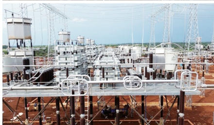
埃塞俄比亚500kV串补项目
