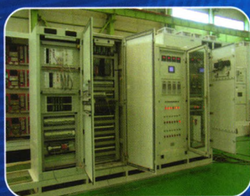
中石油西气东输管线
