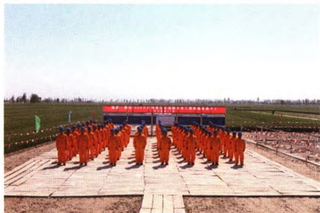
榆横 1000kV 特高压四通一平 石家庄站土建工程
