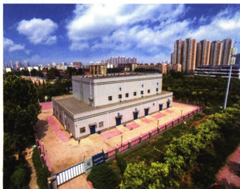
北关 110KV 变电站工程 (国家电网优质工程)
