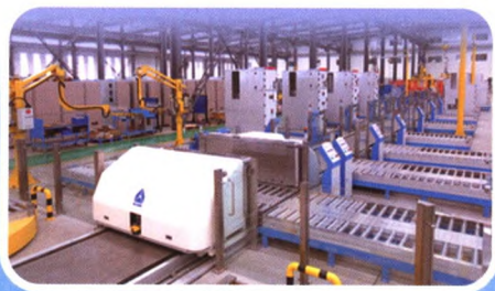
开关柜智能化生产线
