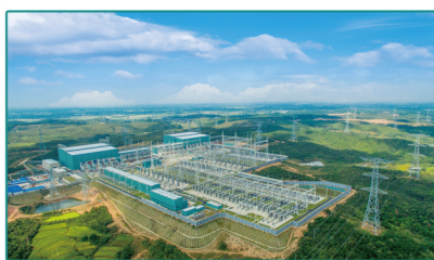
±1100kV直流输电示范工程古泉换流站
