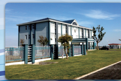
种公猪站大楼
