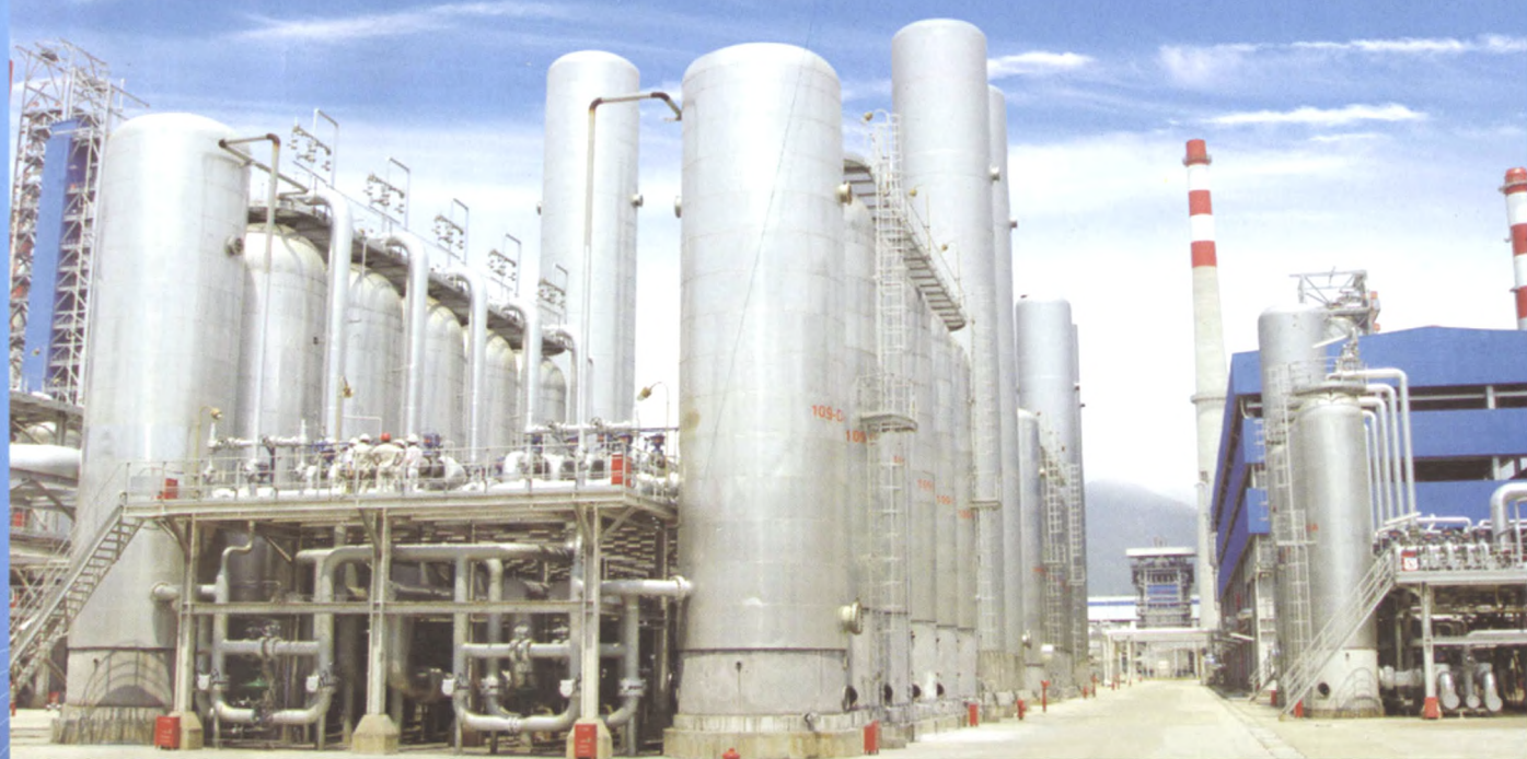
中海油惠州炼油分公司 2 \times 100000\text{m}^3(\text{标})/\text{h} 、 50000\text{m}^3(\text{标})/\text{h} 三套变压吸附变换气提纯氢气装置
