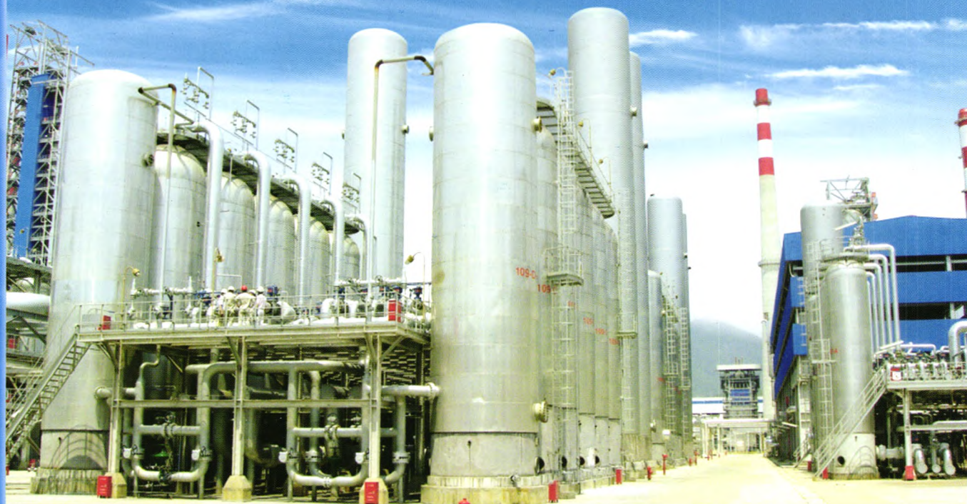
中海油惠州炼油分公司 2 \times 100000 \text{m}^3(\text{标})/\text{h} 、 50000 \text{m}^3(\text{标})/\text{h} 三套变压吸附变换气提纯氢气装置
