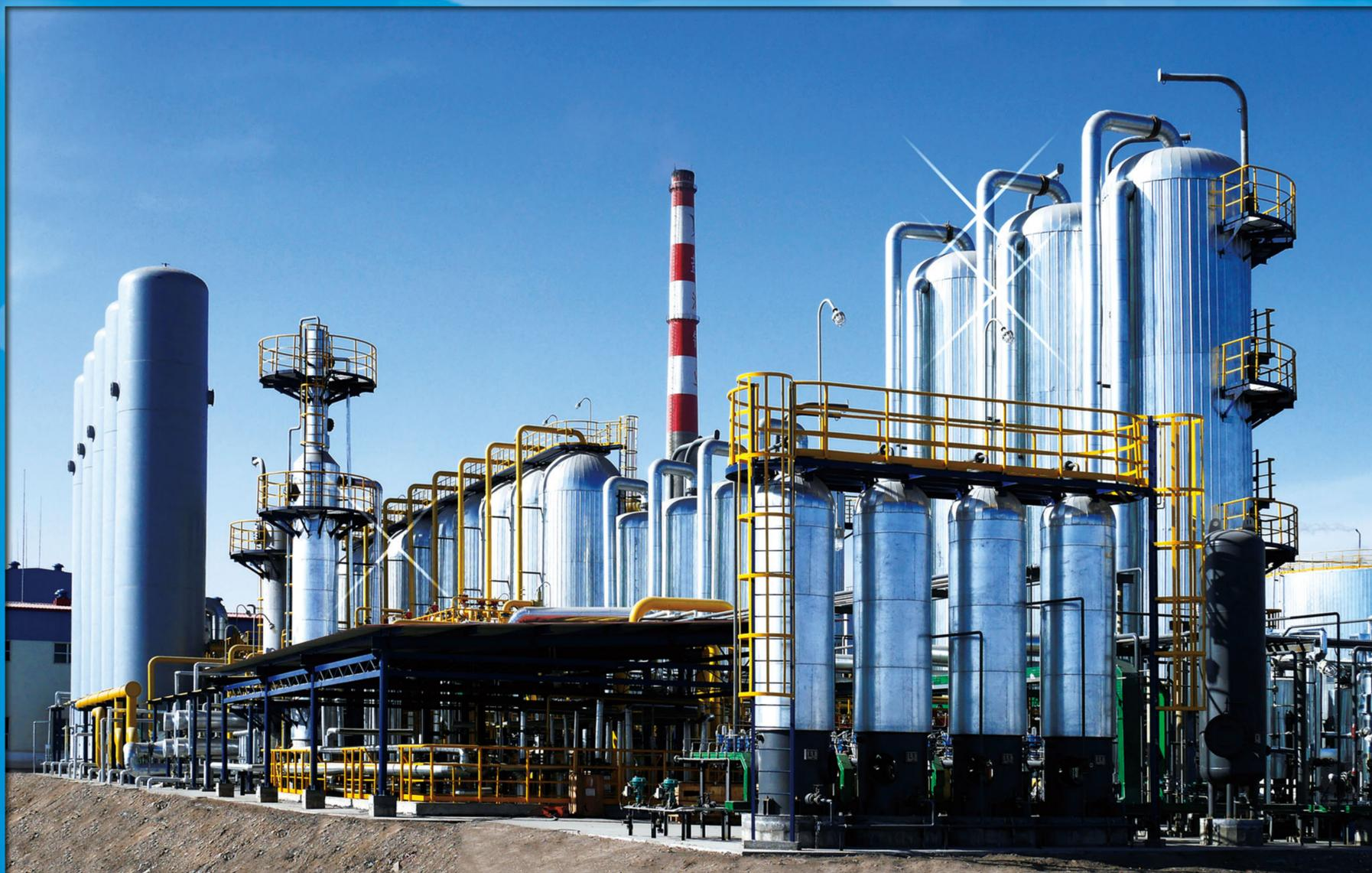
青海盐湖镁业有限公司36500m<sup>3</sup>/h变压吸附焦炉煤气提纯氢气装置
