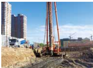
110 桩基础施工新技术专题 讲座(三十七) 内击沉管压灌桩(上)
