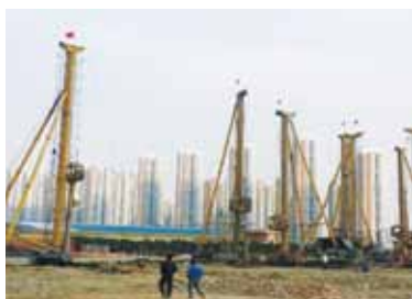
123 桩基础施工新技术专题讲座 (三十五) 内夯式沉管灌注 桩和非取土复合 扩底桩（上）
