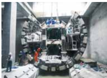
114 长株潭城际铁路开滨区间盾构施 工技术(六) 盾构机正常掘进(下)
