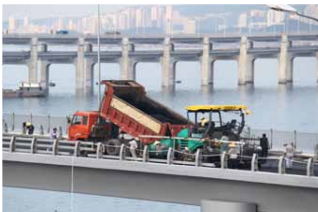
118 德国路面铺装技术新尝试 摩巴产品助力大连南部跨海大桥桥面铺装
