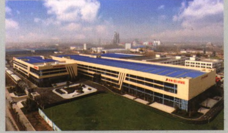
金鹏智能家居产业园
