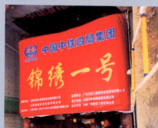
合肥市宿松路综合管廊项目
