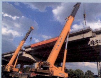
G312快速化改造工程项目
