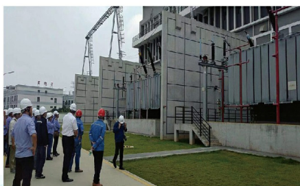
220 kV玉楼站输变电工程
