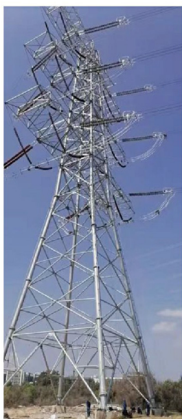
汕汕铁路500 kV电力迁改工程
