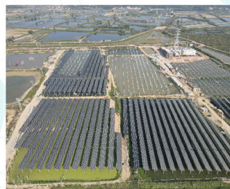
四会200MWP渔光互补 220 kV升压站工程
