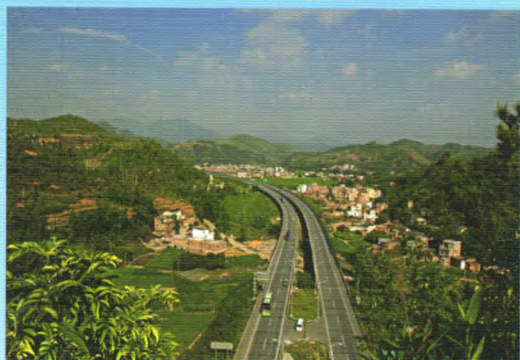
华路公司承担路面交底的云梧高速公路
