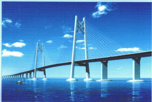
华路公司承担检测任务的港珠澳大桥
