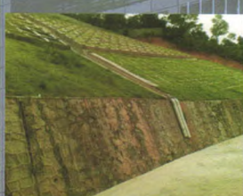
地质灾害治理工程
