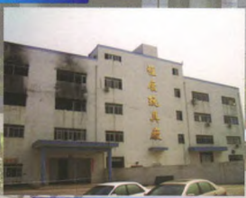
火灾后房屋加固工程
