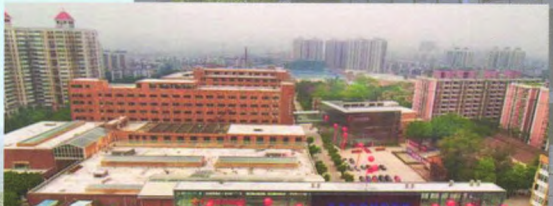
建筑加固改造工程
