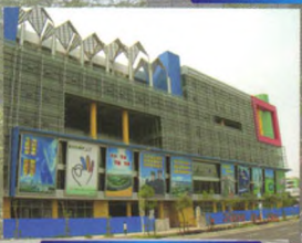
烂尾楼改造升级工程
