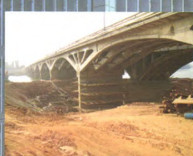
桥梁加固工程
