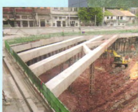
基坑、基础工程
