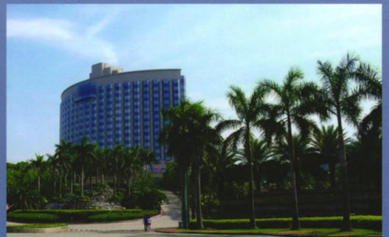
南沙大酒店建筑电气检测
