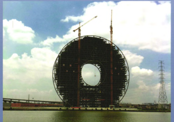
广东塑料交易所总部大楼起重机械检测
