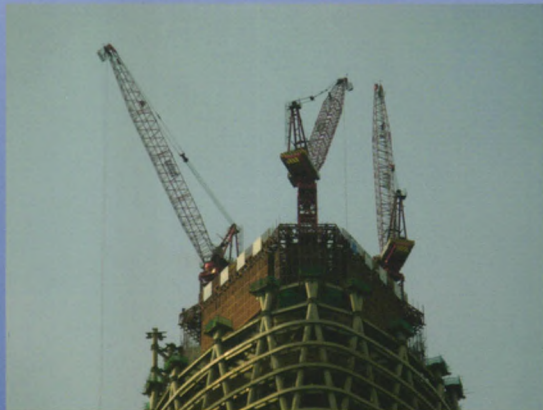
珠江新城西塔动臂塔吊检测
