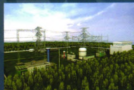
特高压交流试验基地
