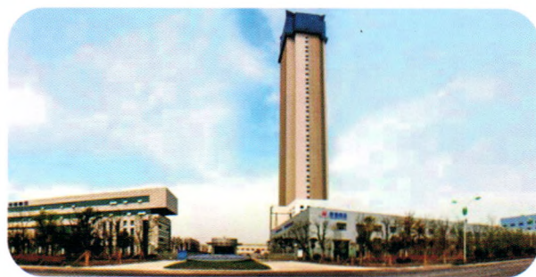
亨通高压厂区图
