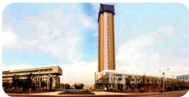
亨通高压厂区图
