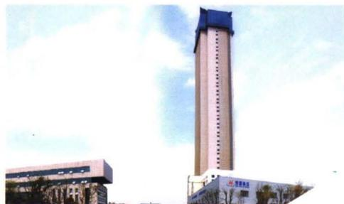
亨通拥有领军亚洲的 180 m 高立塔 VCV 交联生产线。创造了 220 kV 1 x 1600 mm<sup>2</sup> 单根大长度海底电缆连续 25 天生产不停机的世界纪录。
