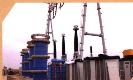
大容量电缆交流耐压试验
