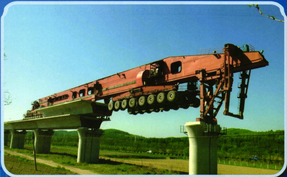
TLJ660 t 架桥机桥面转向装置的设计与研究
