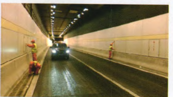
南京扬子江隧道管养工程
